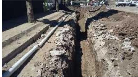
**5).- Jacarandas, de calle San Pedro hasta hacer cerrada al Sur.** Con una inversión de \$268,721.55 se realizó la sustitución de la red principal de drenaje sanitario en tubería de 8" de diámetro y descargas sanitarias de 6" de diámetro PVC serie 25 de norma, y la red principal de agua potable en tubería de 3" de diámetro PVC rd-26 y tomas domiciliarias de 1/2" de diámetro de cobre. Se reestableció el pavimento de esta sección de la calle con una inversión de \$290,257.00.
