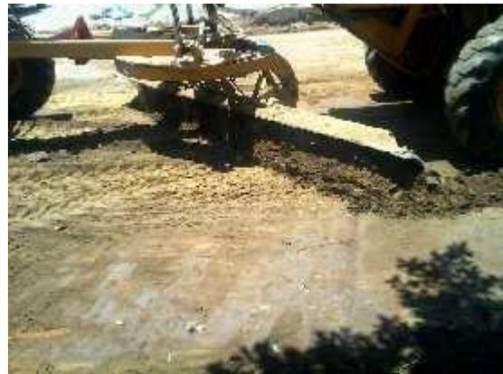
**3).- Calle Fresno, entre Antonio Caso y Madero - Carranza.** Con una inversión de \$3'661,792.21. Consistente en la sustitución de la red principal de drenaje sanitario en tubería de 10" de diámetro y descargas sanitarias de 6" de diámetro PVC serie 25 de norma, y la red principal de agua potable en tubería de 3" de diámetro PVC rd-26 y tomas domiciliarias de 1/2" de polietileno con acero. Se restableció el pavimento de esta sección de la calle.
