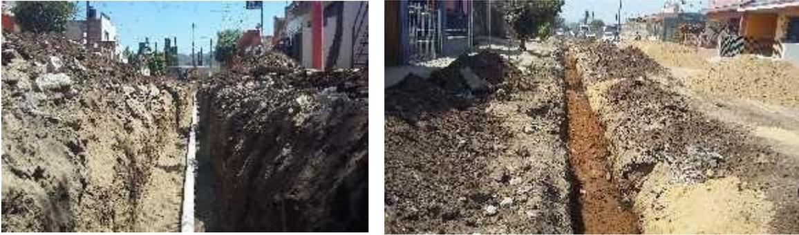
**7).- Parque Industrial al Fresnito.** Con una inversión de \$878,107.17 se realizó la sustitución de la red principal de agua potable en tubería de 3" de acero cédula 40, con una longitud de 910 metros.
