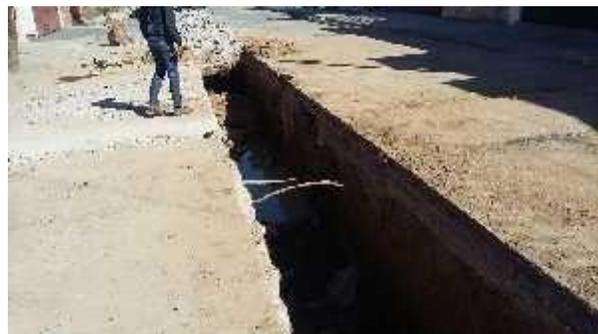
**4).- Gómez Farías, entre Gordiano Guzmán y Francisco Guzmán.** Con una inversión de \$388,024.45 se realizó la sustitución de la red principal de drenaje sanitario en tubería de 8" de diámetro y descargas sanitarias de 6" de diámetro PVC serie 25 de norma, y la red principal de agua potable en tubería de 3" de diámetro PVC rd-26 y tomas domiciliarias de 1/2" de diámetro de cobre. Se reestableció el pavimento de esta sección de la calle con una inversión de \$428,648.36.
