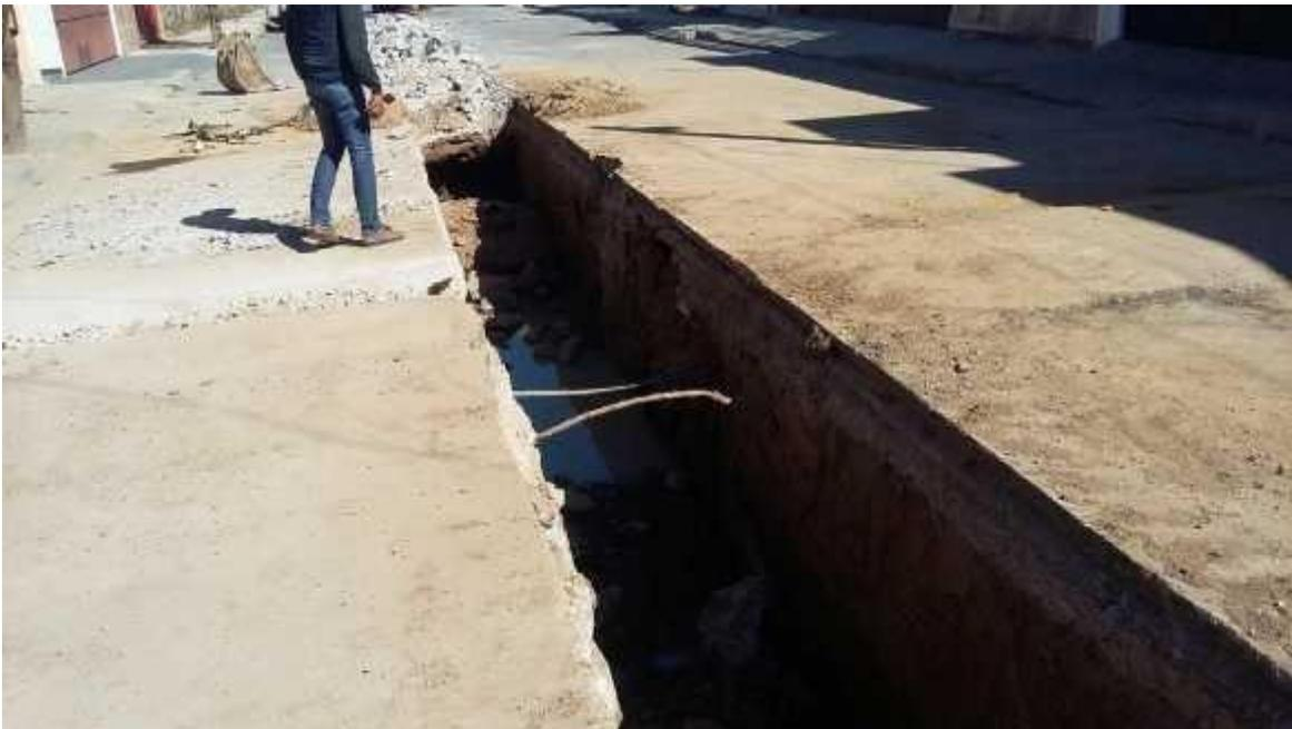
**6).- Amado Aguirre, de calle Medellín a calle Comonfort.** Con una inversión de \$454,226.76 se realizó la sustitución de la red principal de drenaje sanitario en tubería de 10" de diámetro y descargas sanitarias de 6" de diámetro PVC serie 25 de norma y la red principal de agua potable en tubería de 3" de diámetro PVC rd-26 y tomas domiciliarias de 1/2" de diámetro de cobre.
