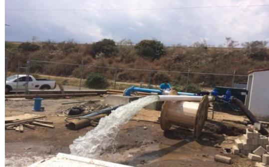
3) Pozo profundo en el Parque industrial, en el que aumentamos el gasto a 15 litros por segundo, con lo que fue posible instalar la línea de conducción de agua potable a la delegación de Apastepetl con una longitud de 1,200 metros y se logró dotar de agua a 450 habitantes.
